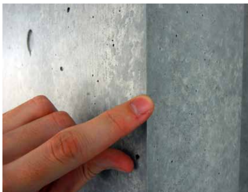
PRECIZNÍ PROVEDENÍ BETONOVÝCH KONSTRUKCÍ, UNIVERZITNÍ KNIHOVNA, TOYO ITO
