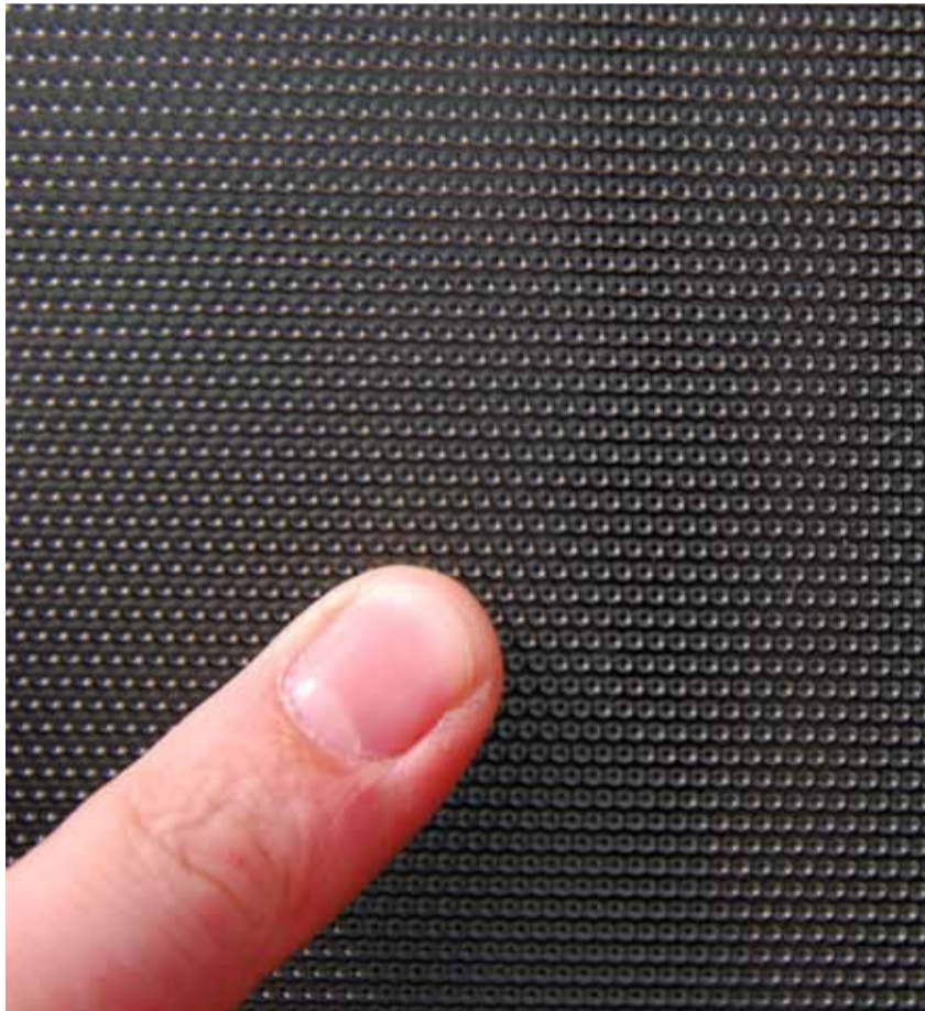
ZASKLENÍ MEDIÁLNÍ FASÁDY JE OPATŘENO MNOŽSTVÍM KONKÁVNÍCH ČOČEK. PŘI BOČNÍM NASVÍCENÍ TABULE SKLA PŮSOBÍ, ŽE SAMA ZÁŘÍ CELOU PLOCHOU KONSTANTNĚ.
